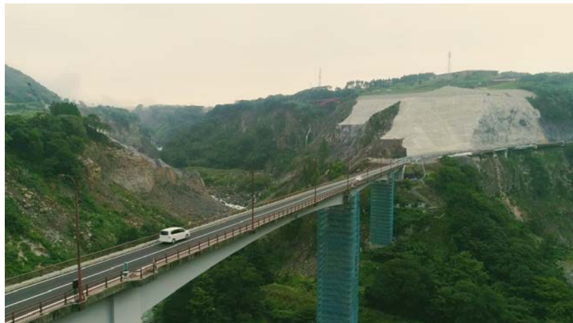
第1回「立野峡谷」より、長陽大橋の空撮カット
