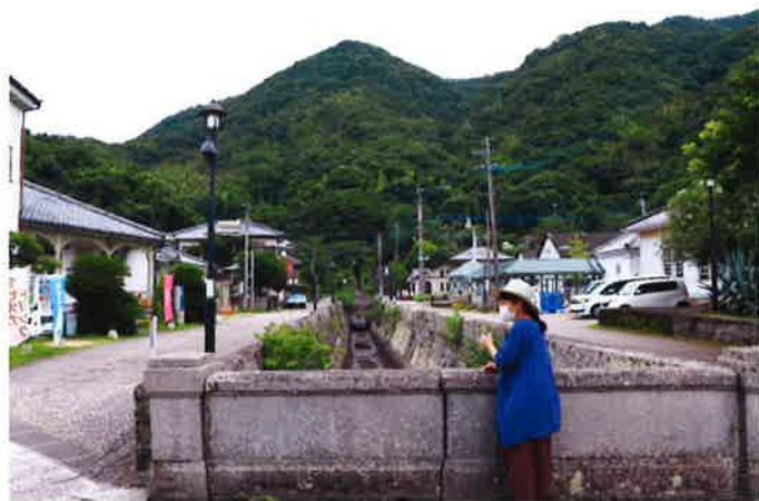
国重要文化財の排水路。海の干満を利用して排水します。
